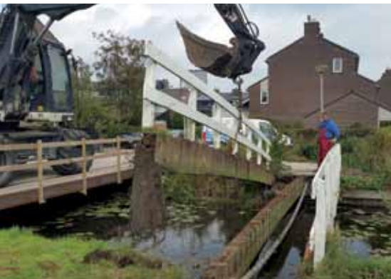
Slopen van de oude brug
