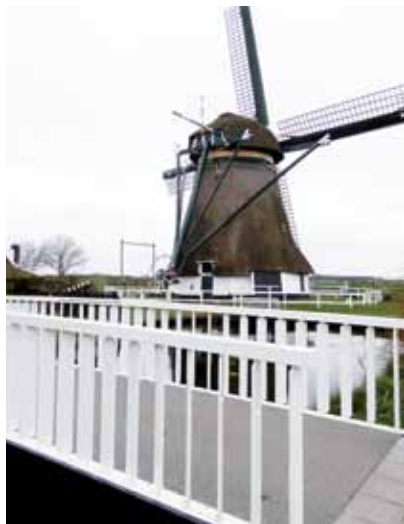
De nieuwe Rademakerbrug
